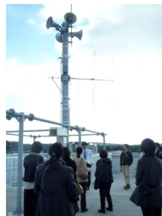
津波避難タワー上層
